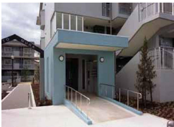
ストック改善の例-スロープ設置 〔県営大宮本村団地〕
