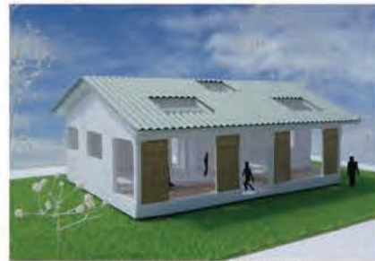
雨側の戸にすだれ格子の開口部を使用した軒風な外観。
