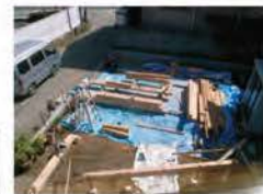
2011年3月、デッキ上棟
