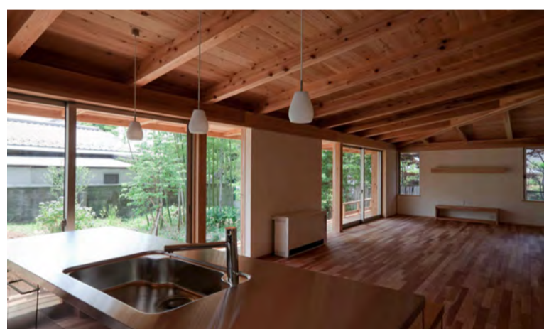
太い柱と梁に囲まれた開放的なリビング。材の再利用を意識して構造体には金物を使用していない。固定化した二酸化炭素を大気に放出させない為にも、木材を長く使うことが大切である。
