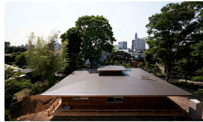
周囲の緑にすっぽりと覆われるような佇まい。屋根には落ち葉や木の実が落ちてくる為、雨樋は取り付けず、雨水はそのまま地面に浸透する。外壁には建主さんが塗装した杉板を張った。
