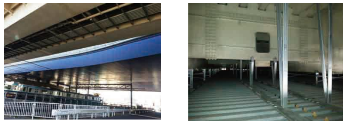
跨線橋設置例（埼玉県／東京外環自動車道 東北線跨線橋）【既設橋】
