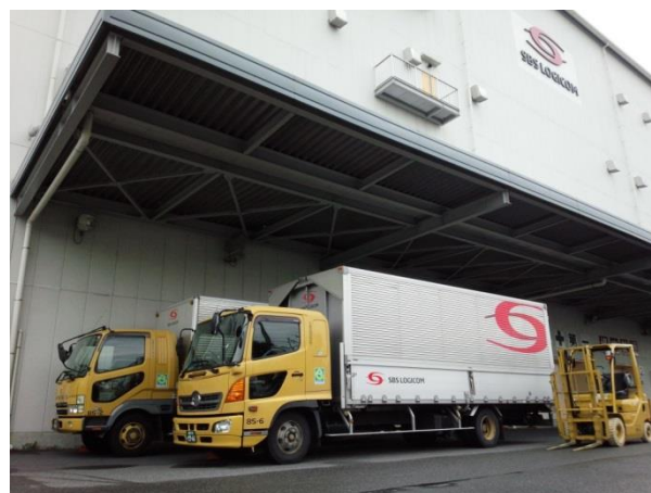
SBSロジコム株式会社吉川支店の外観①
