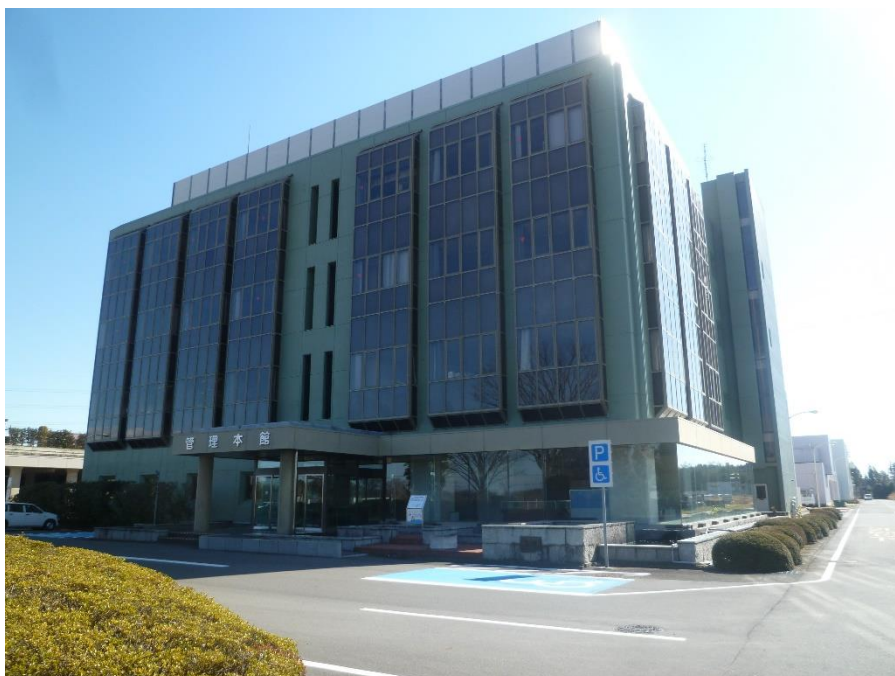
北部支社管理本館
