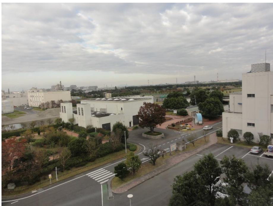
管理棟4階から敷地の全体像を視察
