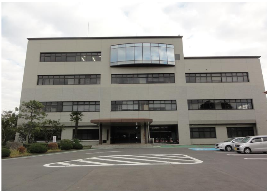
中川下水道事務所および中川支社 管理棟全体像
