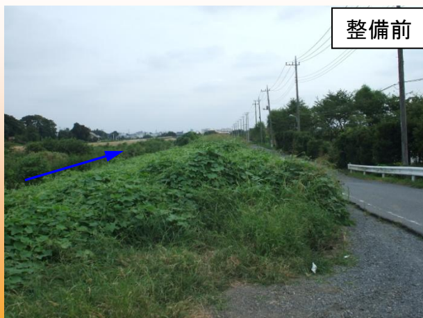
堤防上を雑草が繁茂し、散策できない(H21.9撮影)
