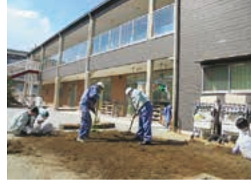
③傷んだ部分を除去し、均す
