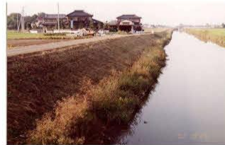
水際部を残した草刈り (水際部には動物の生息環境を提供する機能がある)
