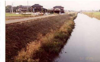
水際部を残した草刈り (水際部には動物の生息環境を提供する機能がある)
