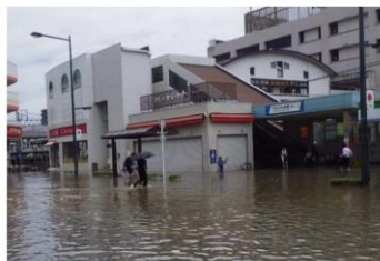
H27.9 浸水被害（越谷市・せんげん台駅前）
