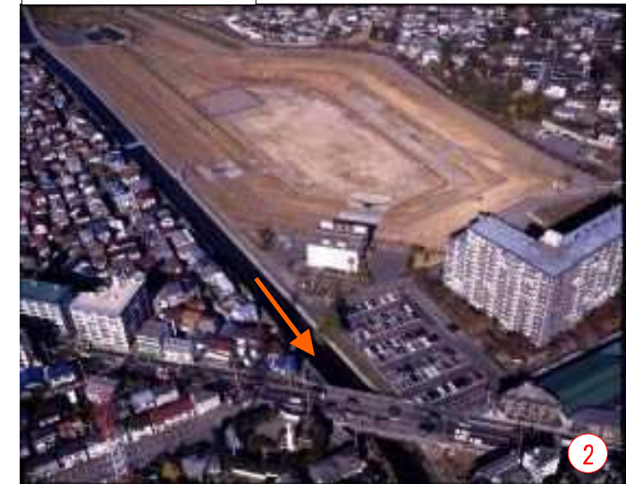
上谷沼調節池
