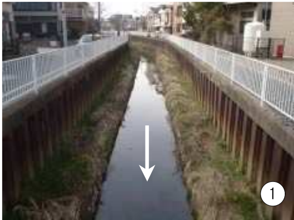
2.4km 付近から上流を望む
