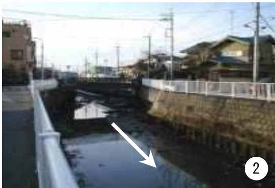
1.0km 付近から上流を望む
