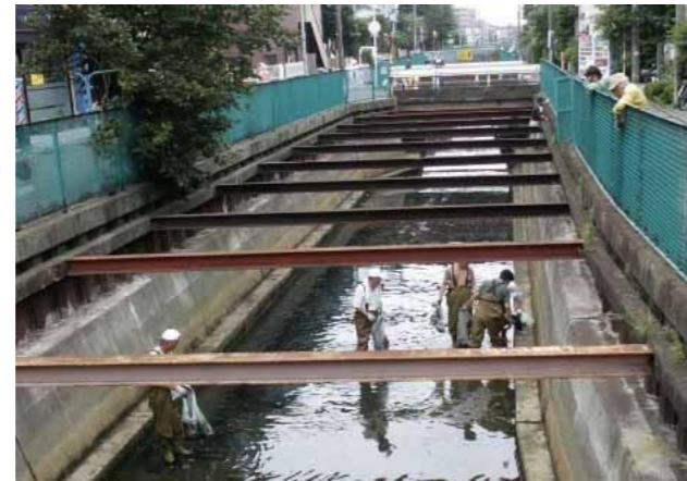
河川沿いの清掃（緑川）
