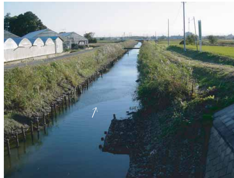
板柵工法が残る4.0km付近
