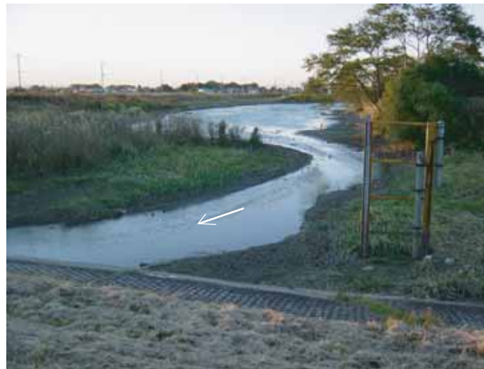
新河岸川放水路合流点付近 (3.0km付近)
