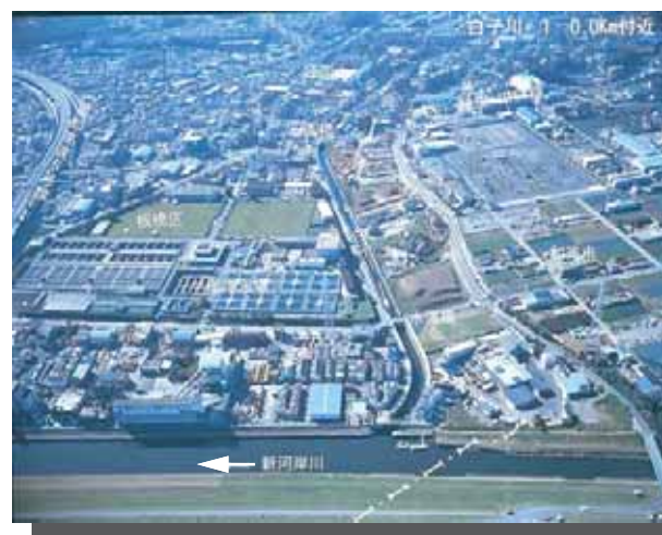
写真① 0.0km付近 沿川には住宅、浄水場、工場が多く立地している。
