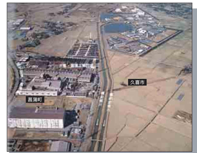
備前前堀川6.0km 付近
