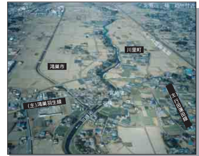
元荒川45km 付近
