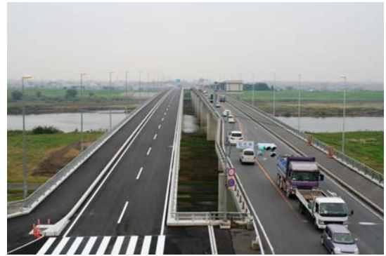
昭和橋整備状況
