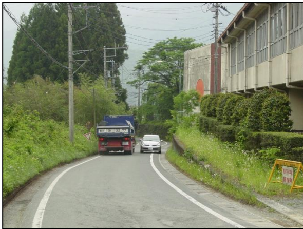
現道の幅員狭小状況（荒川西小学校横）
