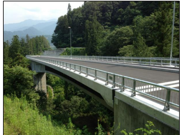
整備状況（贅川橋付近）
