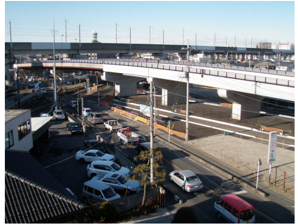
久喜跨線橋整備状況
