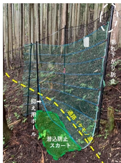
写真3 スリット式ワンウェイゲートの設置
