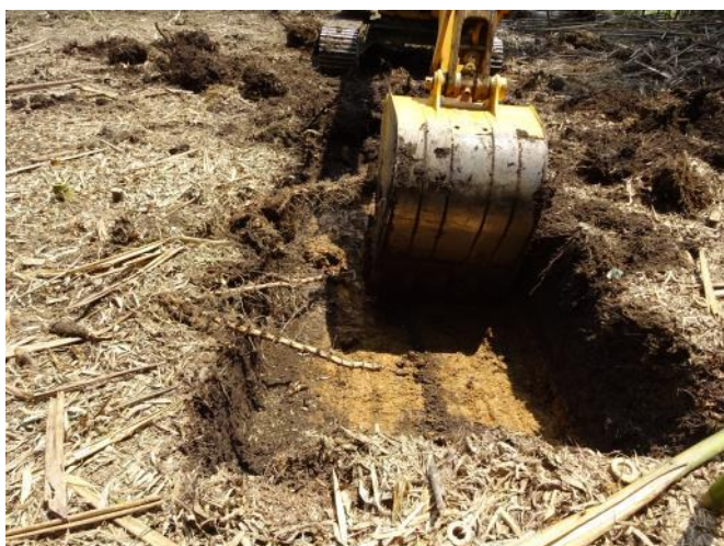
試掘調査風景
