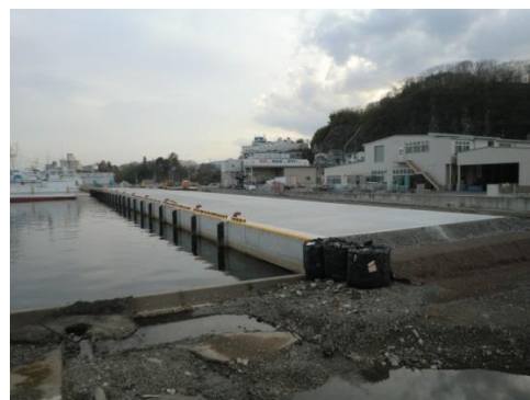
復旧状況 (H26. 3月)
