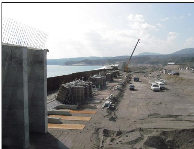
防潮堤造成工事
