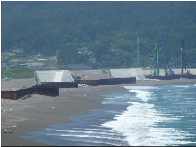
海側から望む防潮堤の復旧状況
