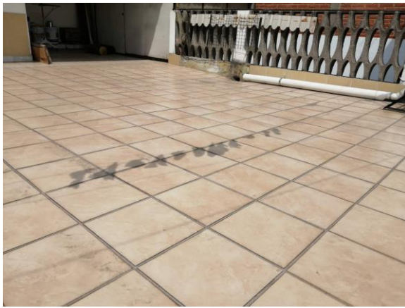
広い屋上では洗濯物干し放題。強い日差しで砂で乾く。 お家によってはアパートなど干すスペースがあまりないところも少なくない。
