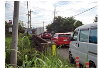
開通前の現道
