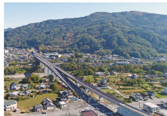
一般国道140号 皆野秩父バイパス(皆野町～秩父市)
