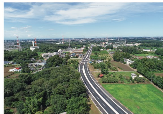
一般国道407号 鶴ヶ島日高バイパス(鶴ヶ島市～日高市)
