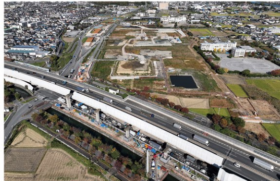
東京外環自動車道 (仮称)外環八潮PA付近(八潮市)
