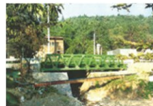
応急復旧 (昭和63年)
