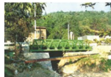
応急復旧 (昭和63年)
