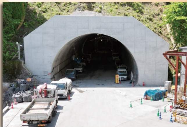
国道140号／大滝トンネル(工事中)
