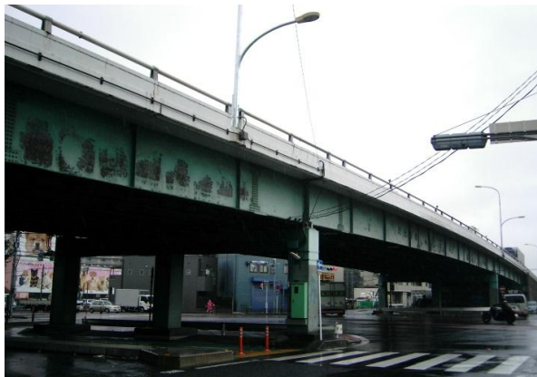
(橋りょう全景)
