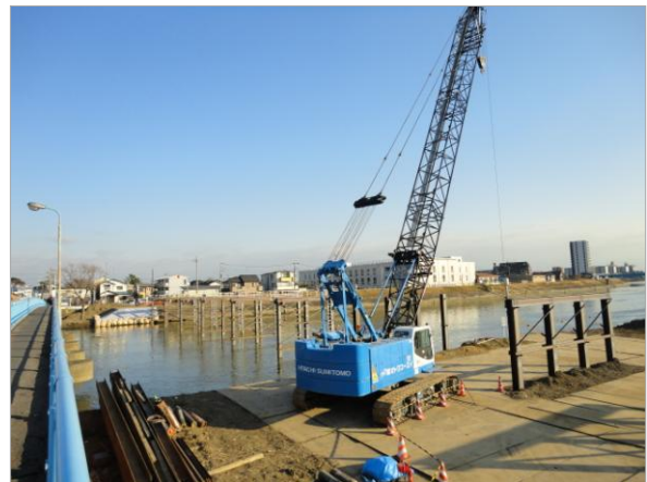
(都) 越谷吉川線 (吉川橋)
