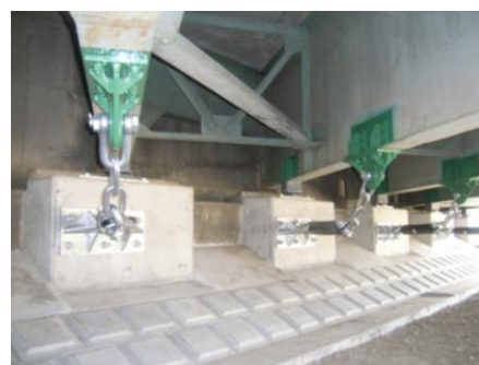
落橋防止装置（チェーン）の例
