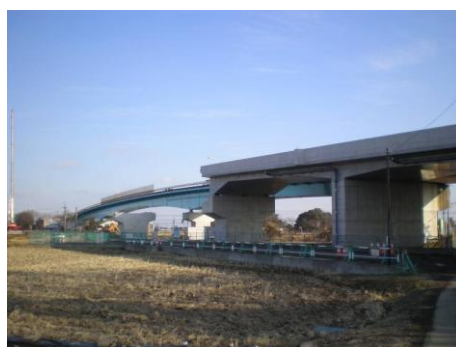
② 行田大橋の整備状況
