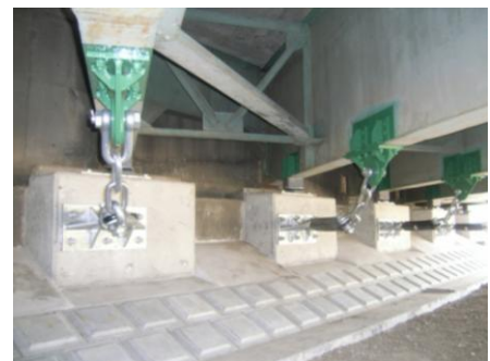
落橋防止装置（チェーン）の例
