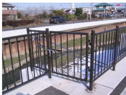
扉付きフェンス設置
