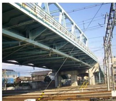
（修繕 橋りょう全景）
