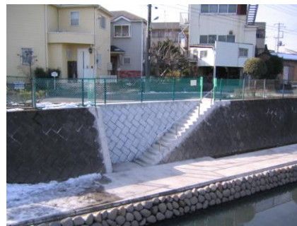
階段通路整備
