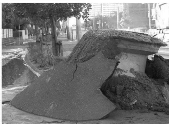
東日本大震災で液状化により浮上したマンホール（千葉県浦安市）
