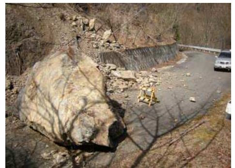
法面崩落により、落石が道路を寸断
