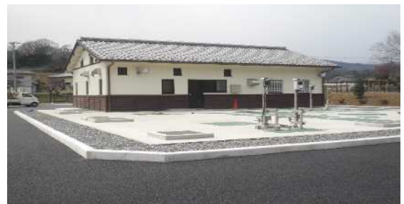
農業集落排水処理施設
