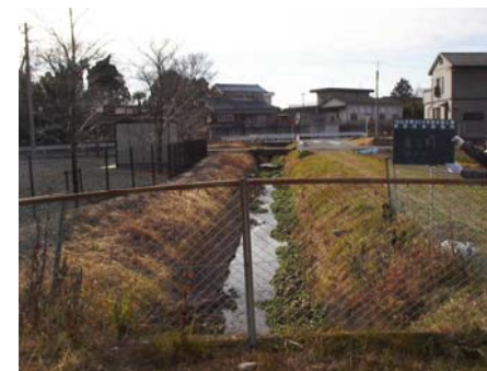
土水路の状況
