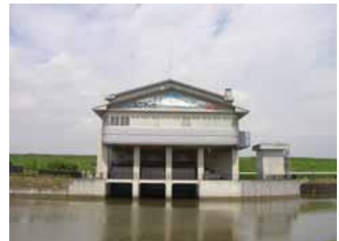
【写真7】新排水機場（事業実施前）
