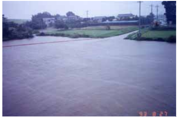
【写真3】排水機場整備後
