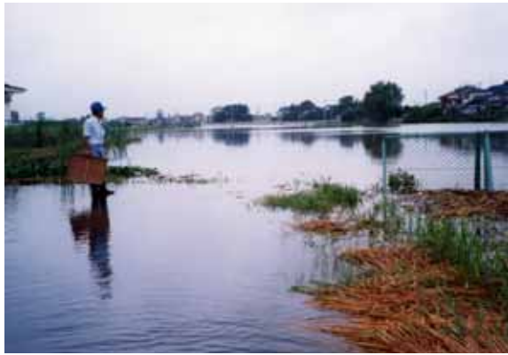
【写真2】排水機場整備前
