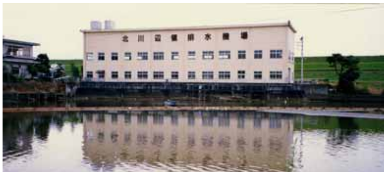
【写真6】旧排水機場（事業実施前）
