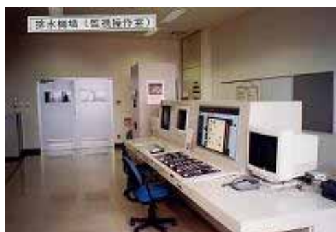
【写真8】排水機場監視操作室（事業実施後）
