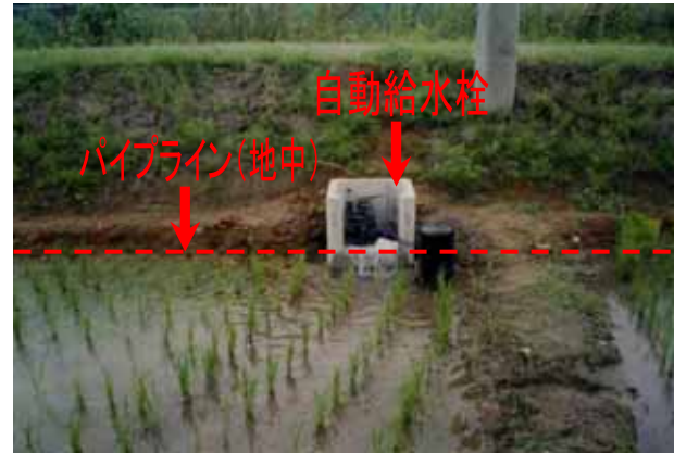
【写真】 本事業により、水の有効利用、水管理の省力化を図るため、用水路をパイプライン化(管水路化)し、自動給水栓(自動的に水位を調節する装置)を設置した。
