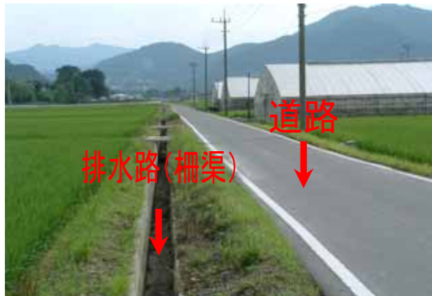
【写真】 本事業により、排水路を柵渠護岸し、水路の余剰地を利用して道路が拡幅された。
