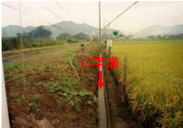
【写真】 用水路はU字溝(開水路)であり、土砂堆積、雑草の繁茂により維持管理に労力がかかる。 また、水路の漏水により水の損失がある。
