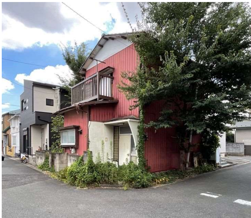
[写真① 物件北西より]
