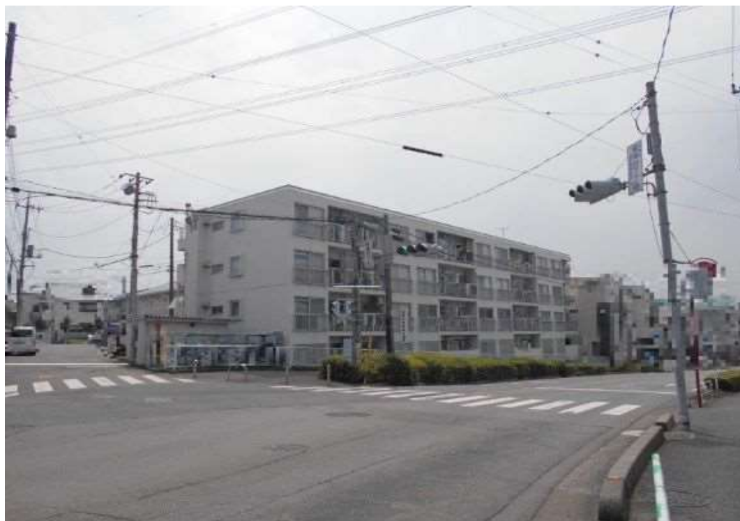
[写真①建物北西側から]
