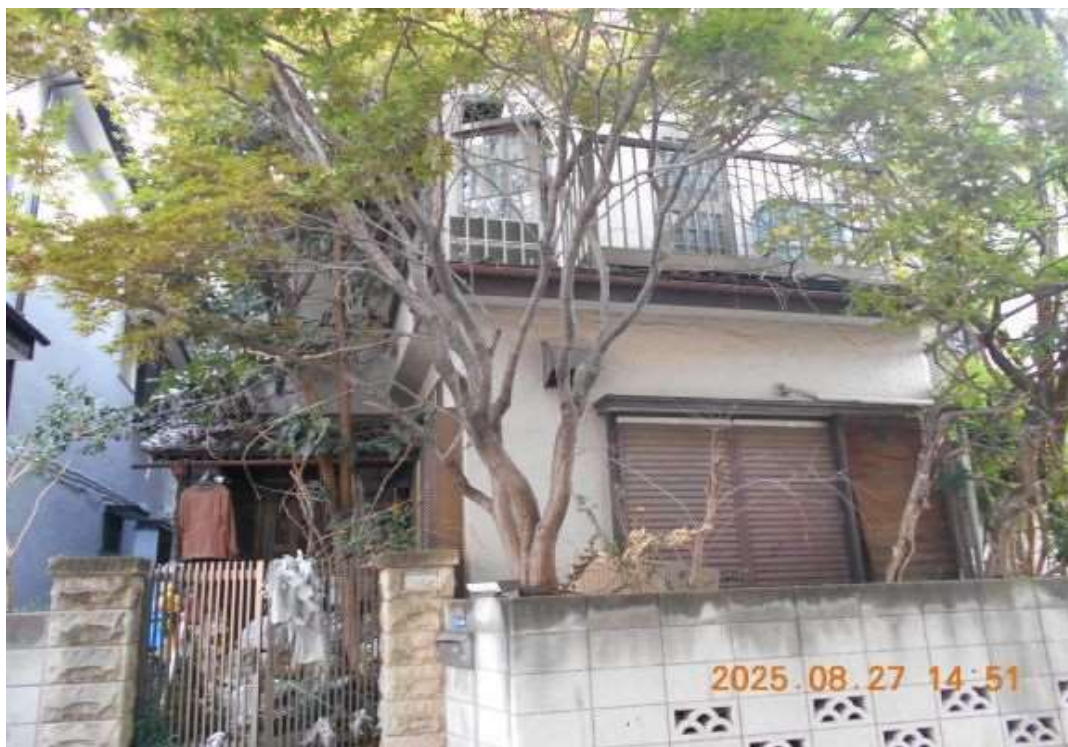
[写真③建物北側から]
