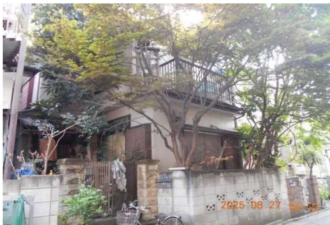
[写真④建物北東側から]
