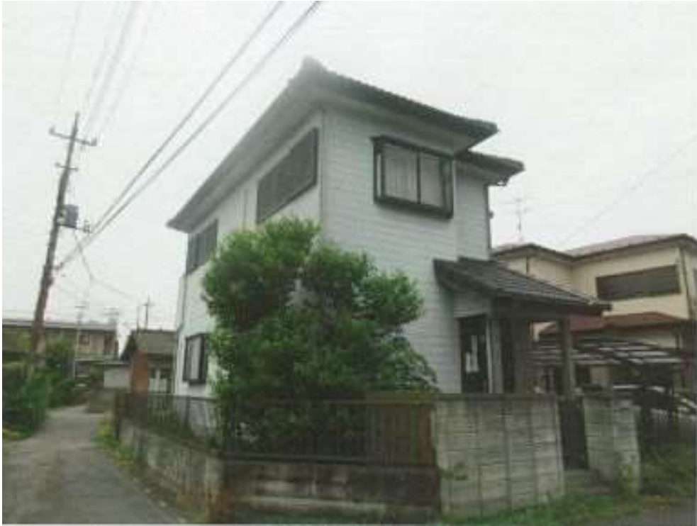
[写真 北東から]
