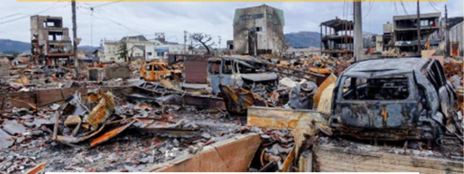
令和6年能登半島地震による輪島市内の被害状況（石川県HPから）
