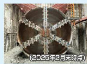
(2025年2月末時点) 掘進が完了しマシンを解体
