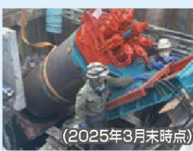
(2025年3月末時点) 雨水流入量調整マンホールの設置
