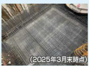
(2025年3月末時点) 排水ポンプ室を構築
