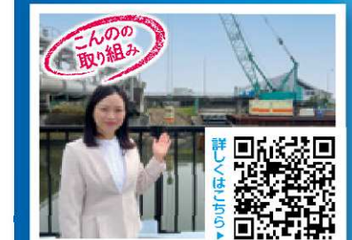
(仮称)戸田公園榎門は着々と工事
