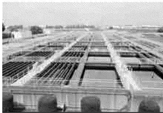
行田浄水場（沈殿池・濾過池）
