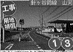
安全に通行できる道路に改築します
