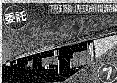
橋りょうを修繕します
