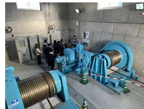
ダムの内部も見学させていただき、その機能や役割を教えてくださいました。
