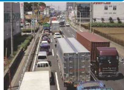
現道の混雑状況（新座市内）
