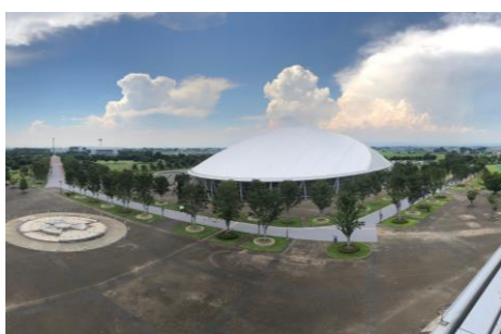
図2 気候変動適応策の例(熊谷スポーツ文化公園に暑熱対策のため植栽および遮熱性舗装の施工を行った)
