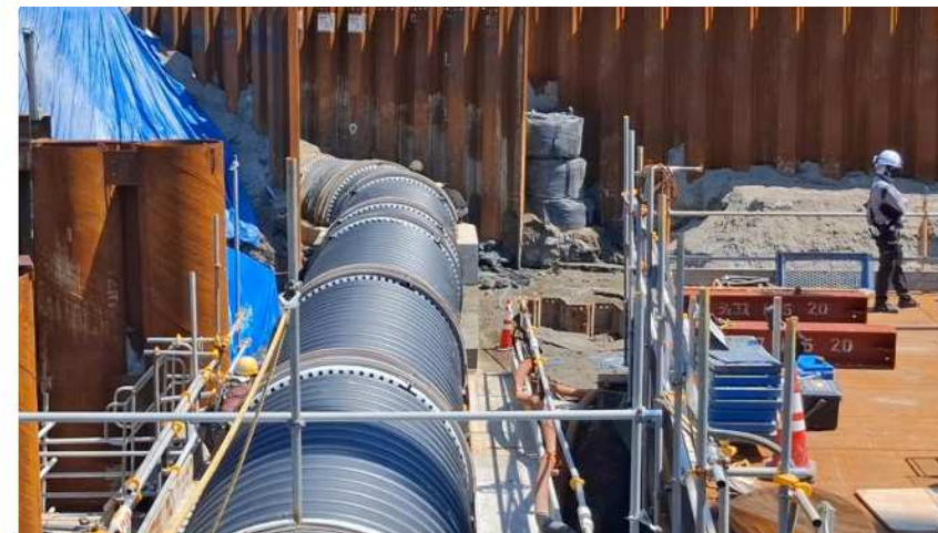
雨水管の仮復旧状況
