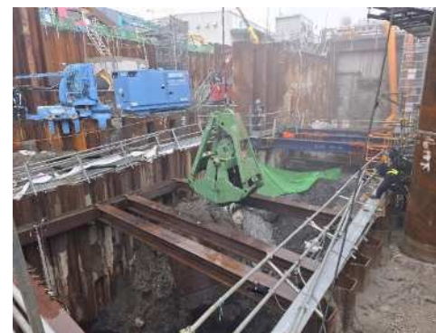
堆積物の引き上げ状況
