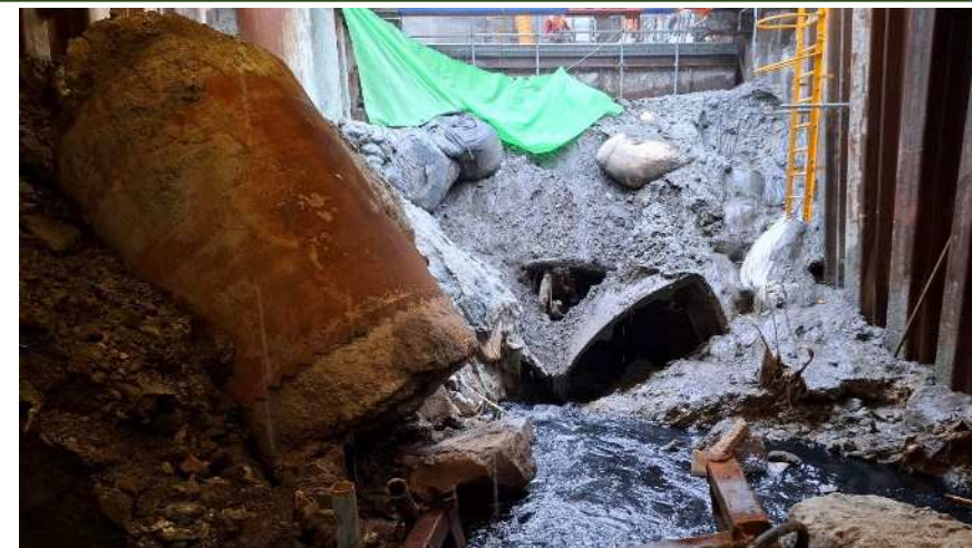
陥没部の土砂やガラの堆積状況
