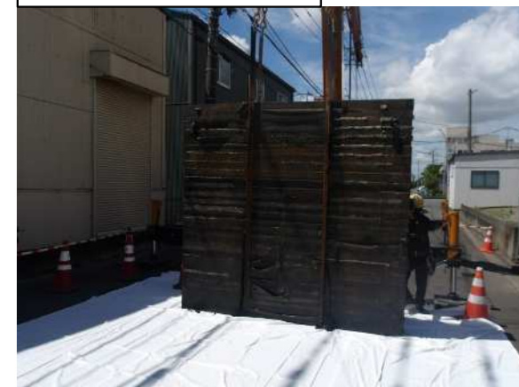
雨水管工事のための角落し
