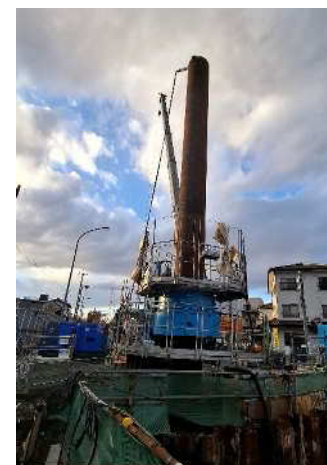
栈橋部鋼管杭打設
