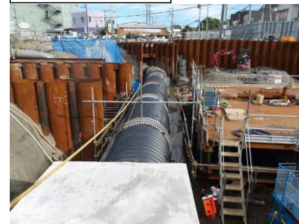
仮雨水管設置状況
