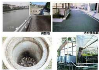
雨水貯留浸透施設の例
