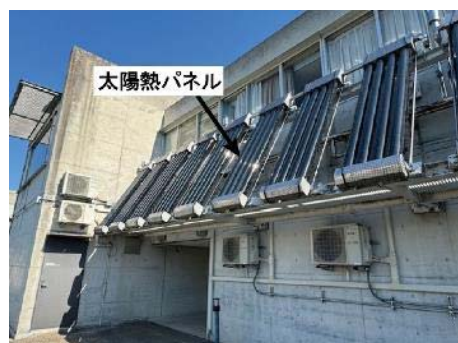
図2 太陽熱パネル（真空管方式）
